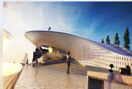
Edificio MAAT (Lisboa)
