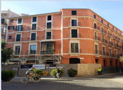
Edificio Plaza Cort (Palma de Mallorca)
