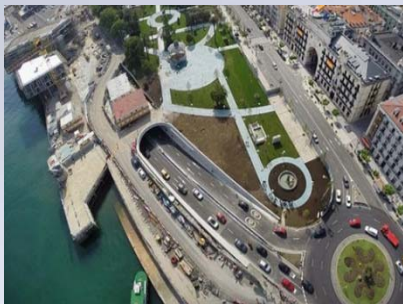
Túnel Centro Botín – Banco Santander (Santander)
