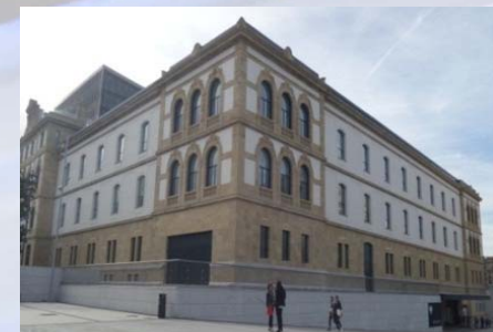
Edificio Tabacalera (San Sebastián)
