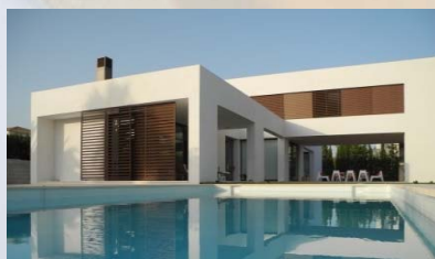
Viviendas de lujo (Alicante)
