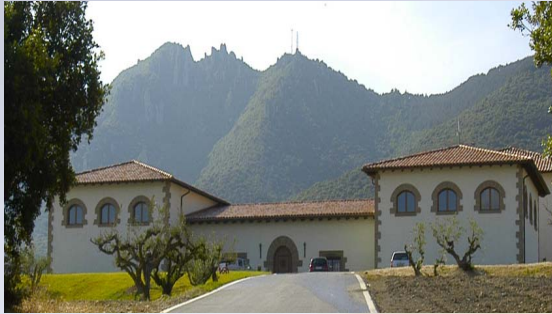
Bodegas Quaderna Vía - Iguzquiza (Navarra)
