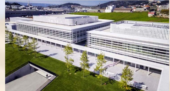
Nuevas oficinas sede central INDITEX – Arteixo (A Coruña)
